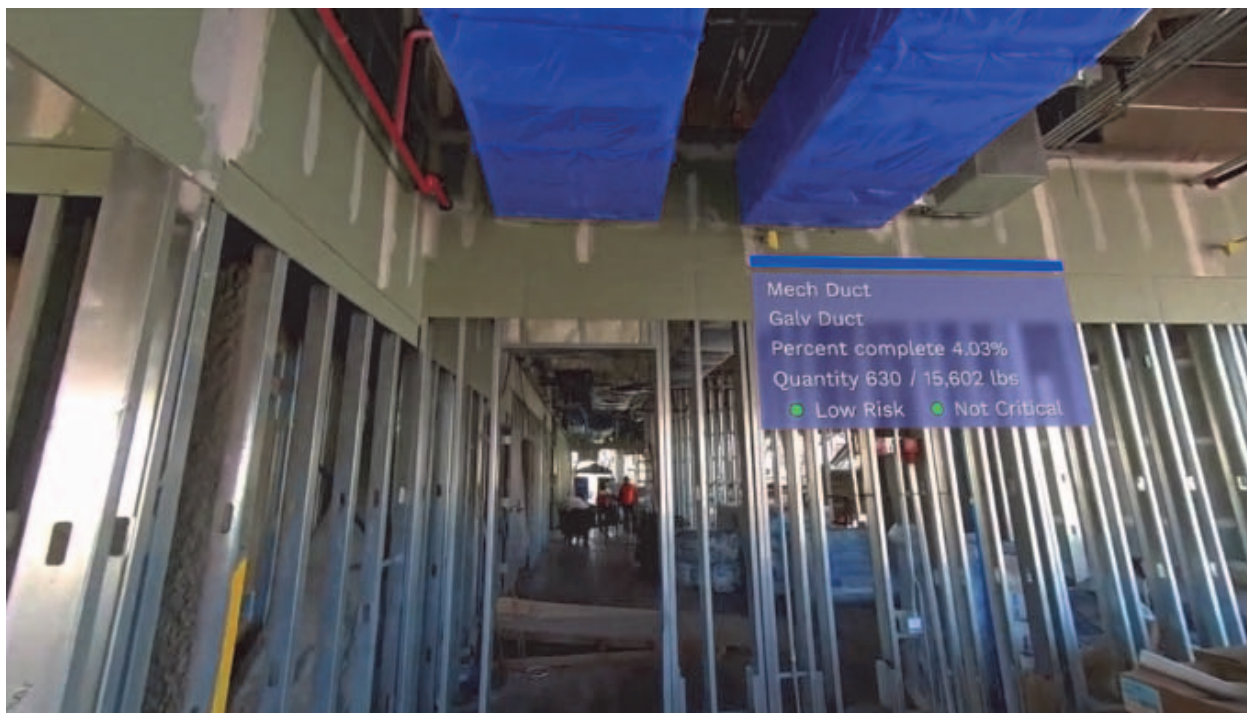
Рисунок 2 - Пример визуализации отслеживания выполнения работ на строительной площадке
